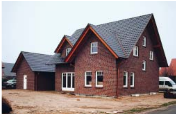
Bild 11: Dieses Referenzobjekt in Ahaus belegt die sehr guten Leistungsdaten einer Kombination von Flächentemperiersystemen in Boden und Decke mit einer Wärmepumpe.
