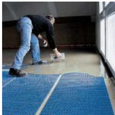
Bild 4: Das Polymat-System, auf Estrich verlegt: Zur Überdeckung reicht eine dünne Ausgleichsschicht von mindestens 2 mm, hinzu kommt nur noch der jeweils gewünschte Bodenbelag.
