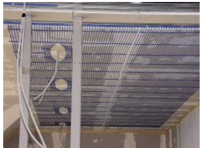
Bild 8: In der Kühlfunktion unschlagbar, kommen sie bislang bei der Planung von Flächenheizsystemen oftmals zu kurz. Dabei sind allerdings hierfür geradezu prädestiniert: die Decken.
