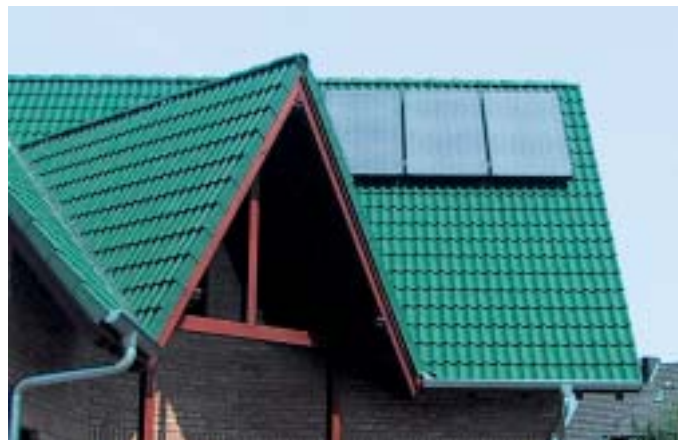
Bild 12: Auch dem Wunsch des Bauherrn nach Einbindung von Solarkollektoren in die Wärmepumpenanlage kann entsprochen werden. Die zusätzliche Einbindung einer solaren Heizungsunterstützung durch Röhren- oder Flächen-Kollektoren ist über einen Kombispeicher ohne weiteres möglich.
