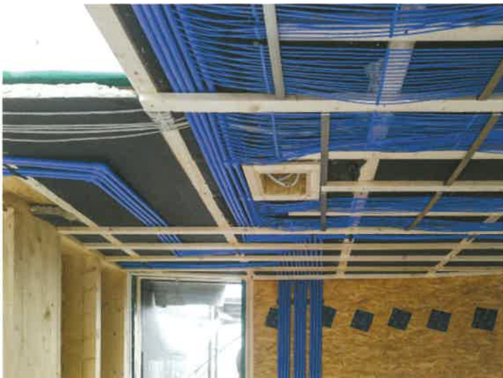
Clina Kapillarrohrmatten Einbausituation
