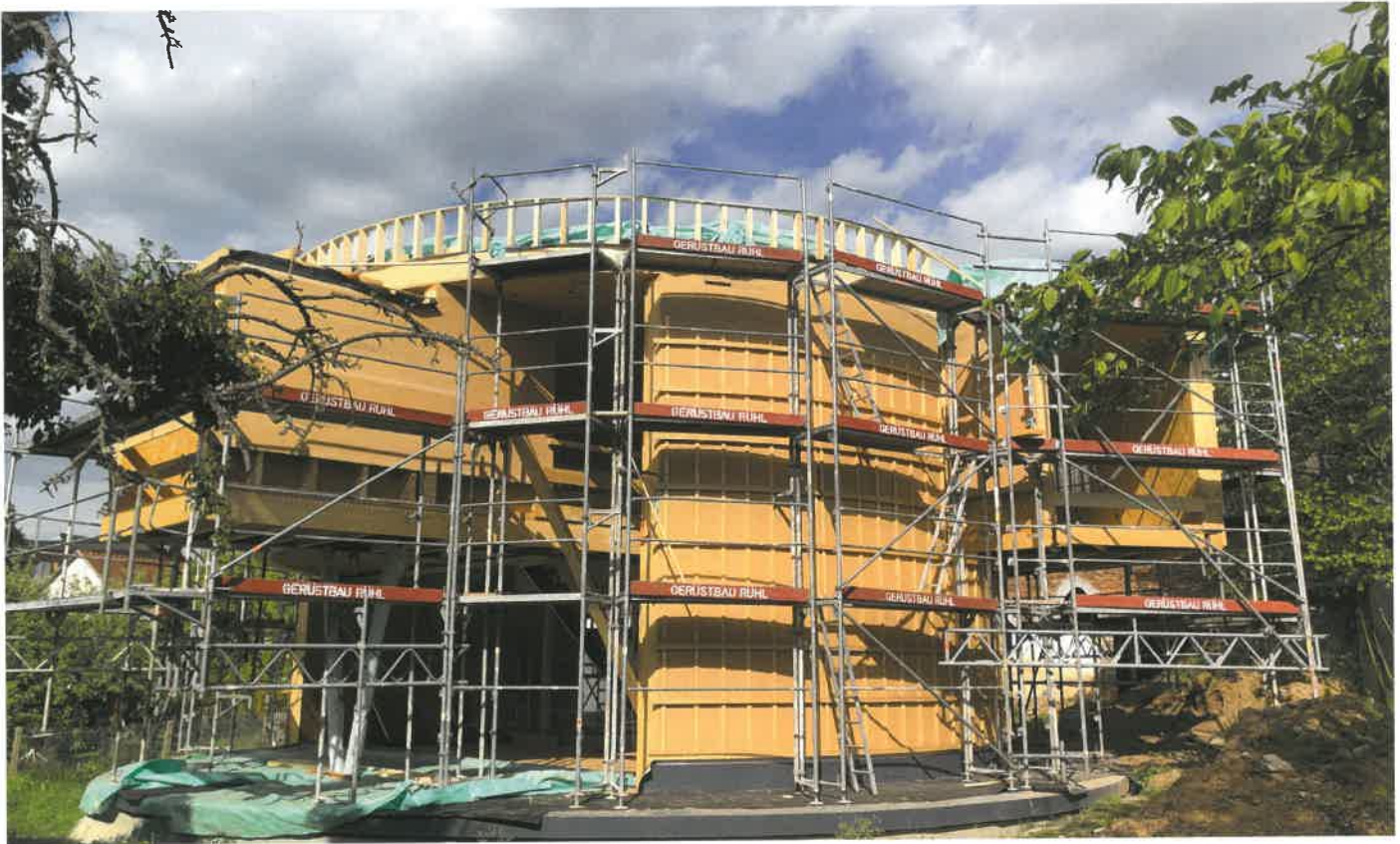
Drehhaus Nr. 4 im Bau © DrehHaus GmbH
