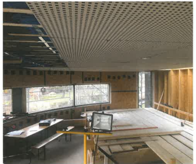
Heiz-/Kühldecke, Beplankungsphase ©DrehHaus GmbH
