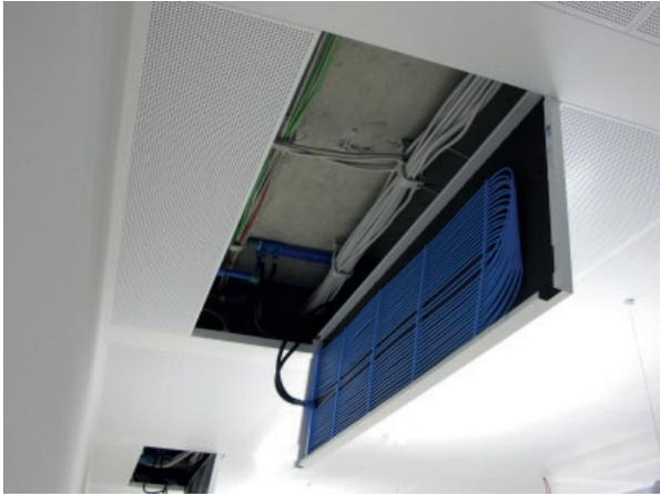
Die Kapillarrohrmatte wird bei ungelochten Kassetten direkt auf dem Metall und bei gelochten Kassetten, die auf der Innenseite meist mit einem Akustikvlies bedeckt sind, auf dem Vlies fixiert, i.d.R. mit Kleber.
