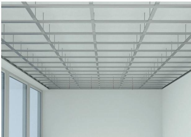
Die OPTIPANEL 18 werden quer zu den Profilen einer Unterkonstruktion mittels Knauf-Caps in den Löchern angeschraubt.
