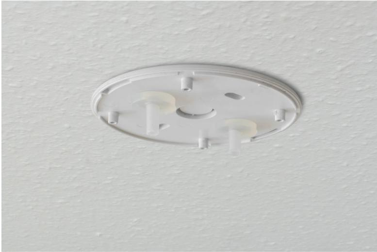
Die beiden Enden der „Fühlerröhrchen“ so abschneiden, dass diese ausgehend von der Grundplatte maximal 10 mm lang sind.
