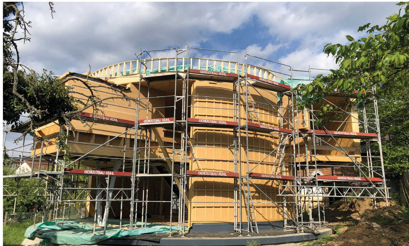
Drehhaus Nr. 4 im Bau © DrehHaus GmbH
