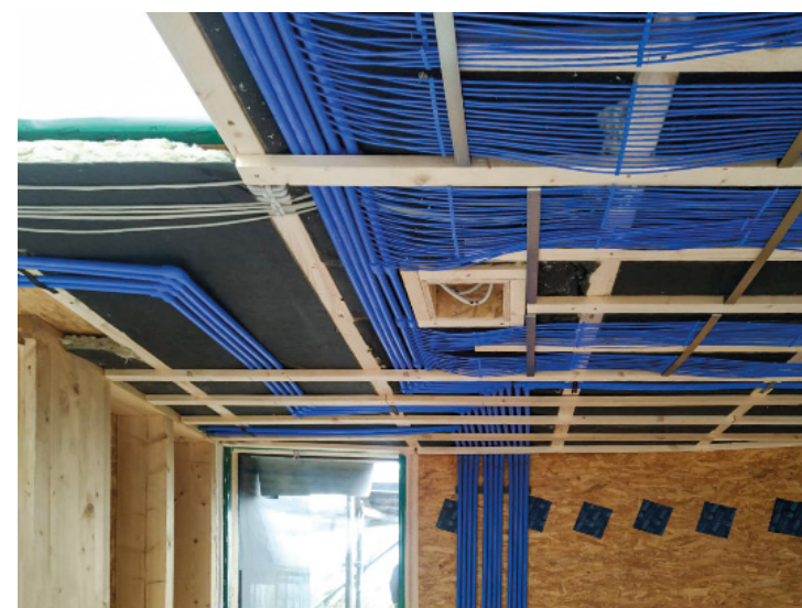
Clina Kapillarrohrmatten Einbausituation
