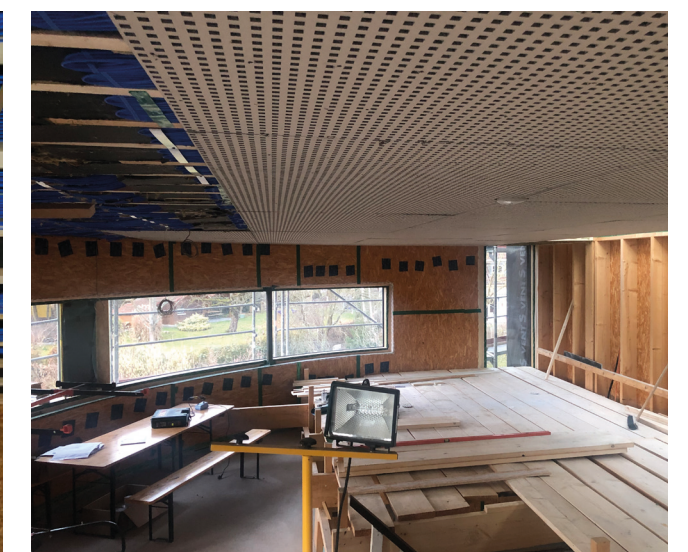
Heiz-/Kühldecke, Beplankungsphase ©DrehHaus GmbH
