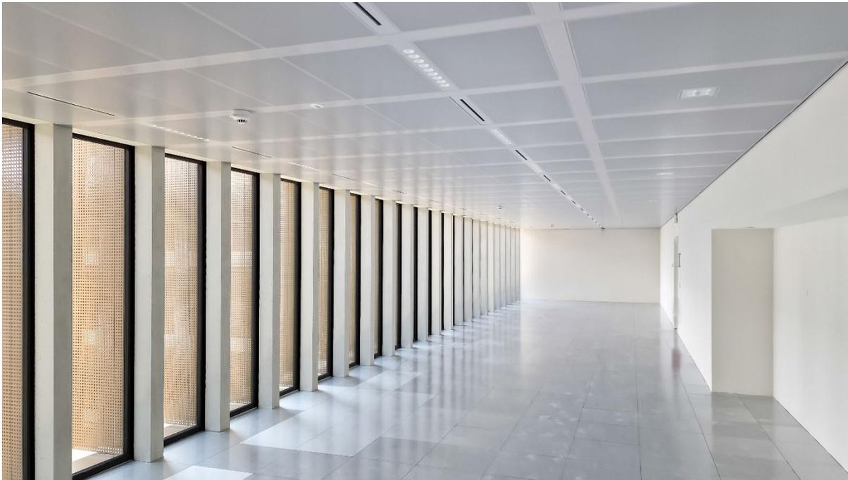
**Ausführung:** Metaldecke | Bandrasterdecke mit Metallkassetten mit rückseitig fixierten Kapillarrohrmatten, Heiz- und Kühlfunktion
