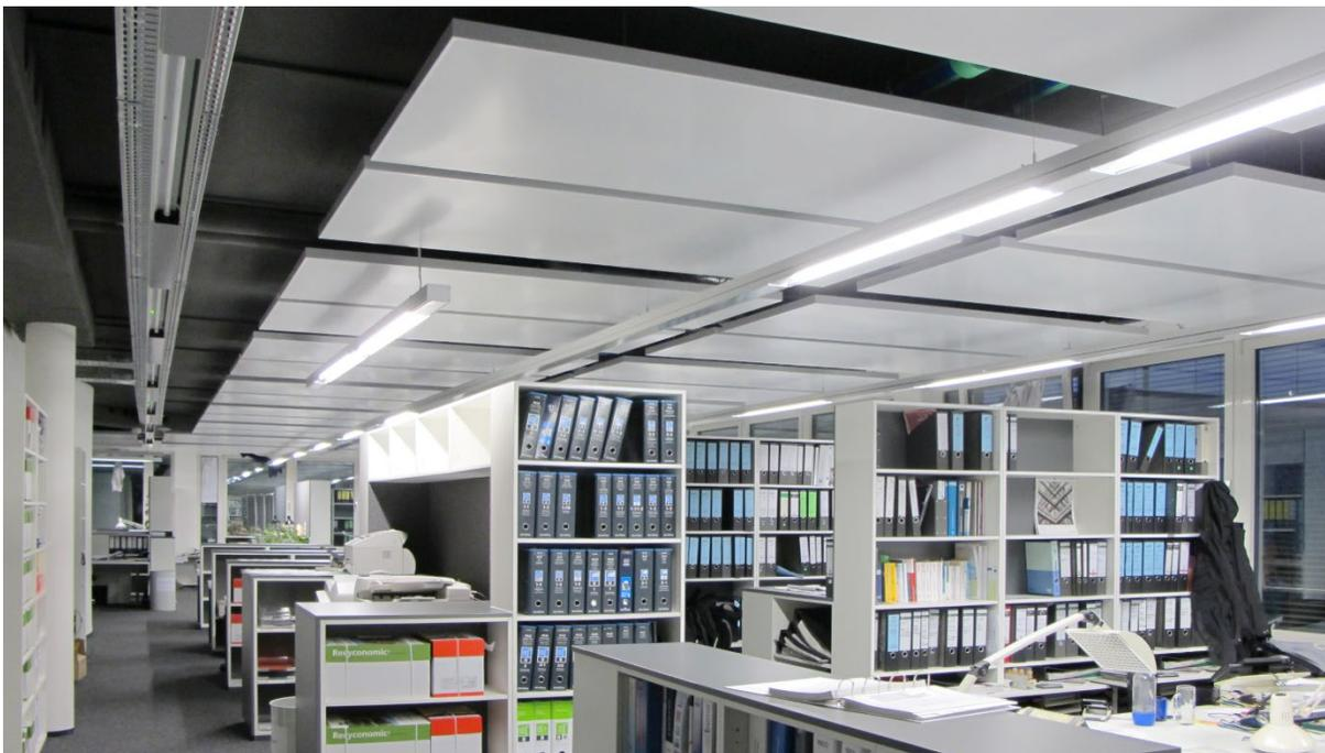
**Einsatzbereich:** Deckensegel | Metallsegel mit Kapillarrohrmatte, die auf der Innenseite des Segels fixiert ist, Heiz- und Kühlfunktion
