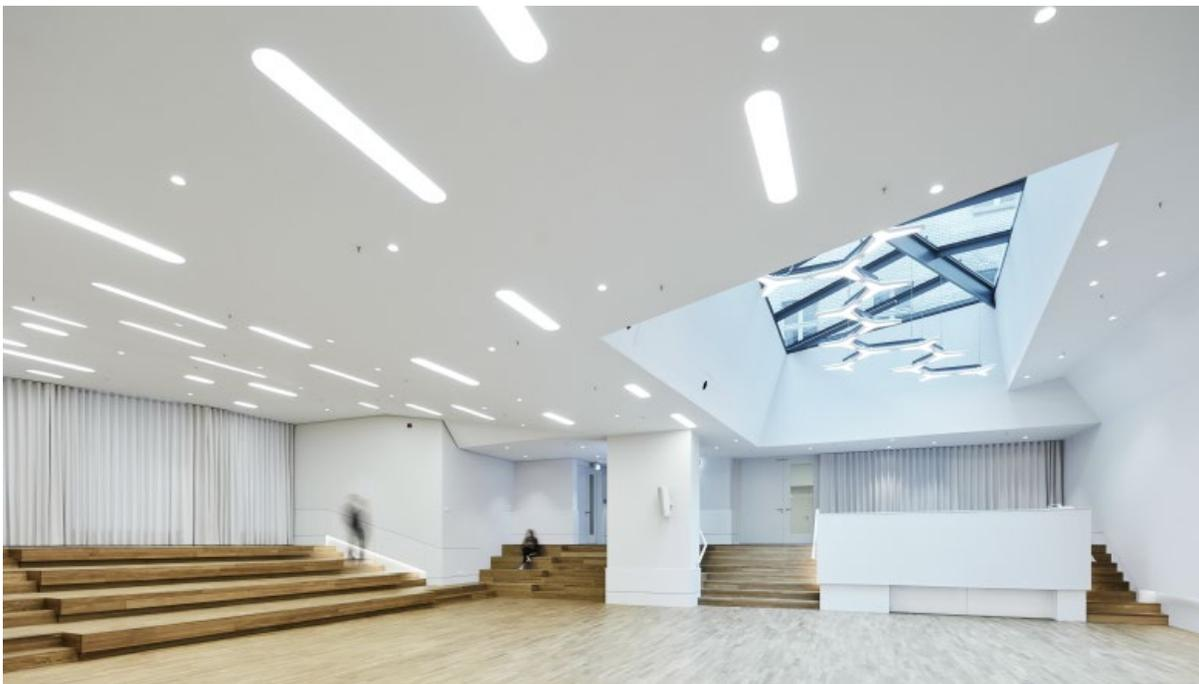
**Ausführung:** Putzdecke | Putz an Gipskarton mit eingeputzter Kapillarrohrmatte, Heiz- und Kühlfunktion,
