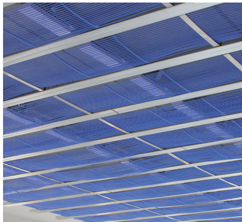
Bild 2: Heiz- und Kühldecke mit Kapillarrohrmatten sowie Teile der Trockenbauunterkonstruktion vor der Beplankung mit Gipskartonplatten, Quelle: Clina Heiz- und Kühlelemente GmbH, www.clina.de
